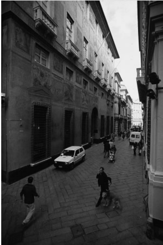
5-6. Facciata di palazzo Spinola in Strada Nuova a Genova, dopo il restauro del 2004
